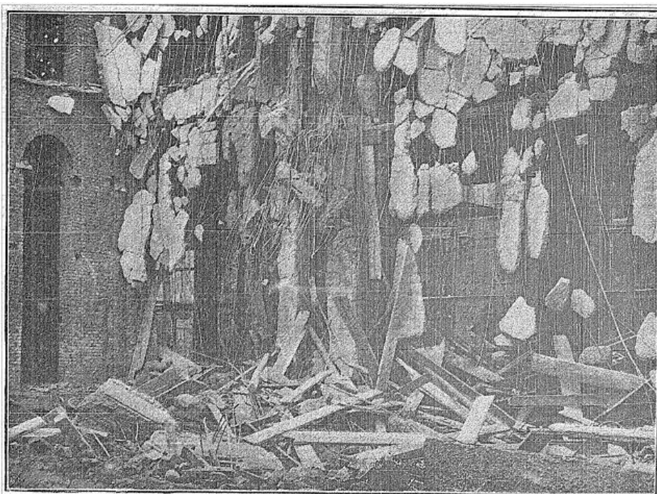
L'aspetto che presentava l'edificio della Cooperativa subito dopo il crollo del tetto in cemento armato. Le vittime sono sepolte a sinistra. (Fot. Comercio)
