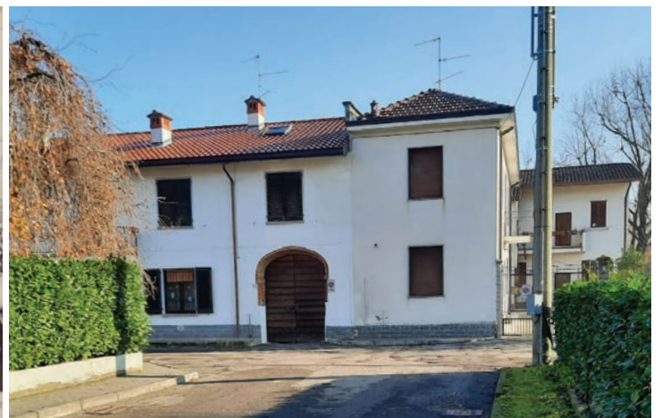
L'antica chiesa una volta cessata la funzione venne dismessa e per buona parte demolita. Nell'attuale struttura sono ancora conservate porzioni di muratura della chiesa, l'antica cantina e la statua di sant'Antonio custodita dalla famiglia Fenaroli.
